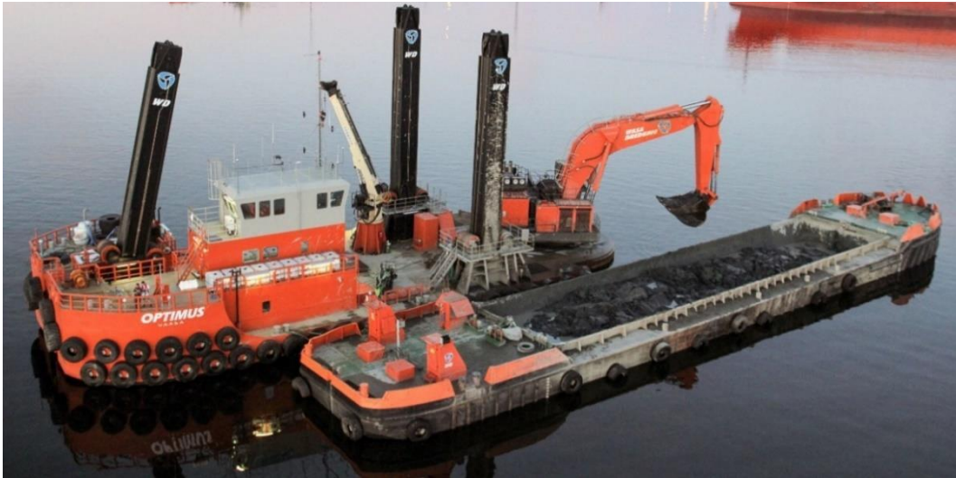
Figur 7. Exempel på enskopeverk som lastar en bogserad pråm.
