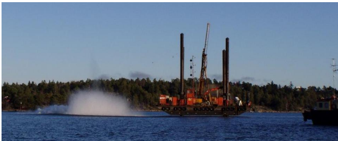
Figur 9. Undervattenssprängning från en borrhplattform.
