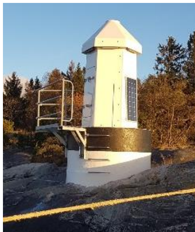
Figur 15. Farledsutmärkning, exempel på verkligt utförande av kummel där den vita kroppen fasadbelyses.
