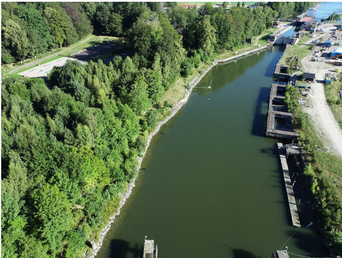
Figur 4. Området nedströms sluss i Lilla Edet. Drönarfoto mot norr. Längs med den västra strandlinjen syns befintliga erosionsskydd tydligt.
