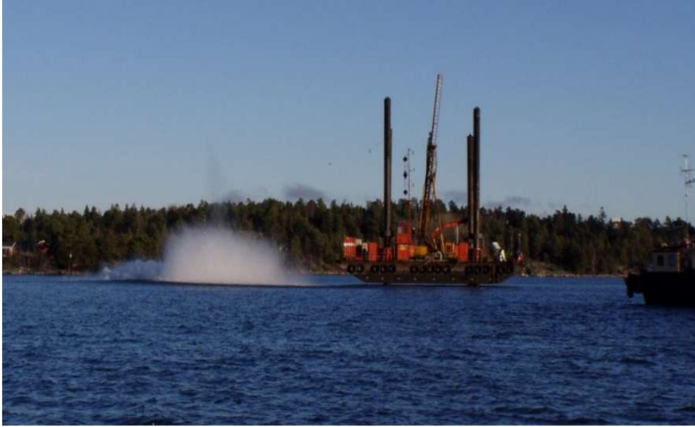
Figur 5-11. Undervattenssprängning där borrhålen borrades från en borrhplattform, en s k jack-up rigg.
