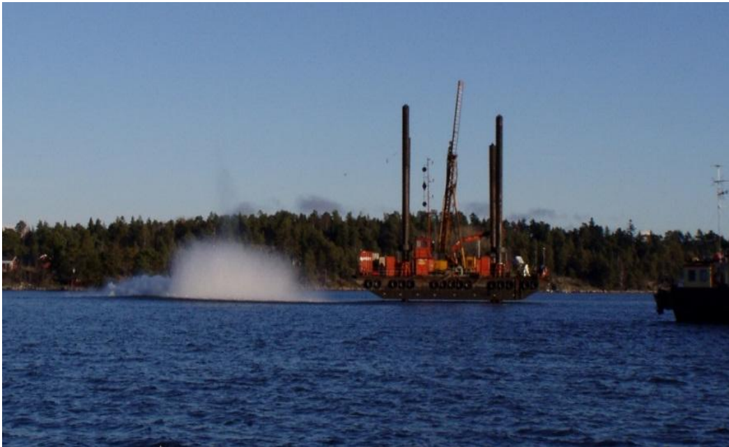
Figur 19. Undervattenssprängning där borrhålen borrades från en borrhplattform, en sk jack-up rigg.
