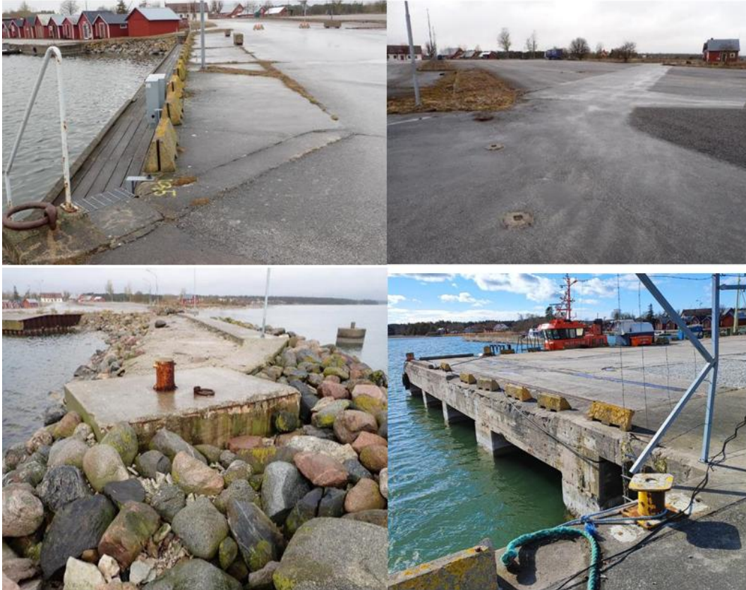
Figur 5. Foton från befintlig hamn. Överst till vänster: inre kaj, vy mot väst. Överst till höger: terminalyta, vy mot nordväst. Underst till vänster: vågbrytare, vy mot nordväst. Underst till höger: yttre kaj, vy mot väst.
