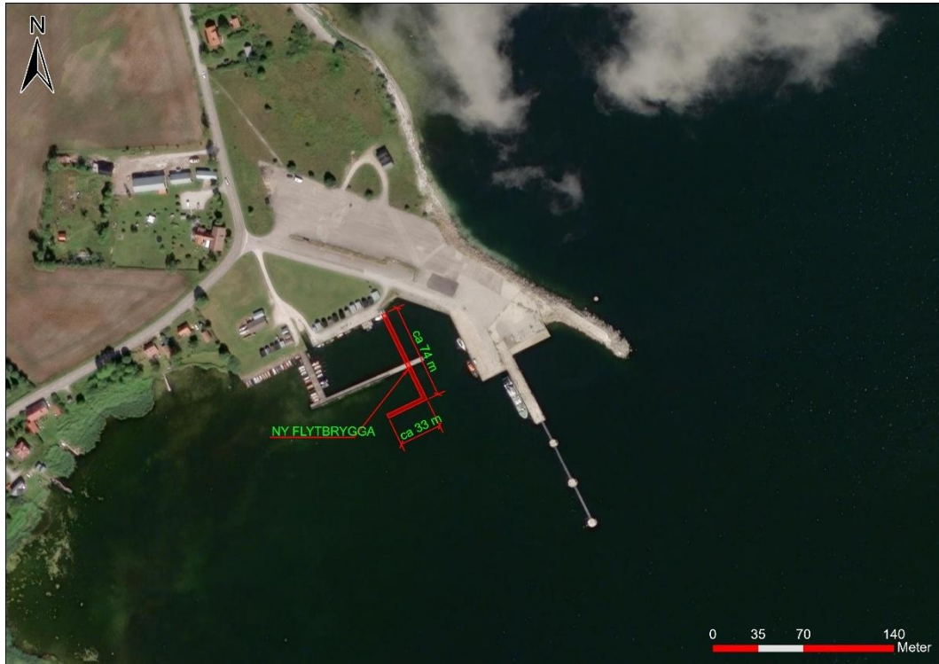
Figur 41. Ny flytbrygga i anslutning till småbåtshamnen.
