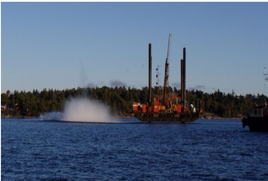
Figur 28. Undervattenssprängning där borrhålen borrades från en borrplattform, Jack-up rigg.
